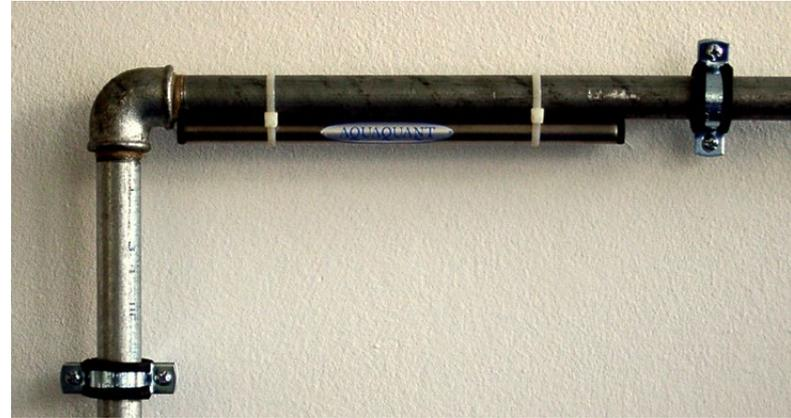
Abb. 3: Montage des AQT 1526 an der Wasserleitung
